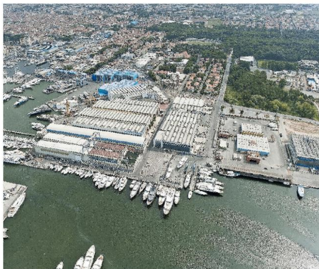
Un'immagine dall'alto dei cantieri della Darsena FOTOD'ARCHIVIO
