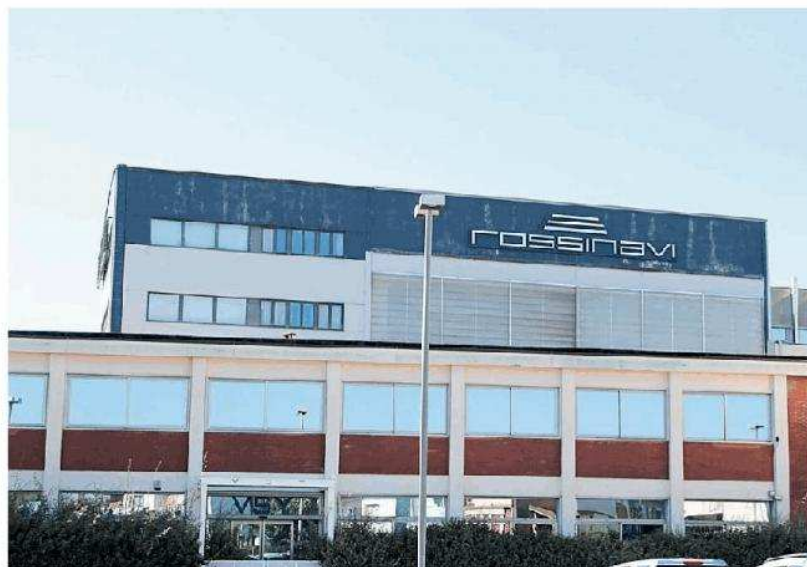
Il cantiere Rossi Navi in ambito Polo Nautico FOTO GIURCA/PAGLIANTI
