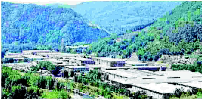
Lo stabilimento Lucart di Diecimo
