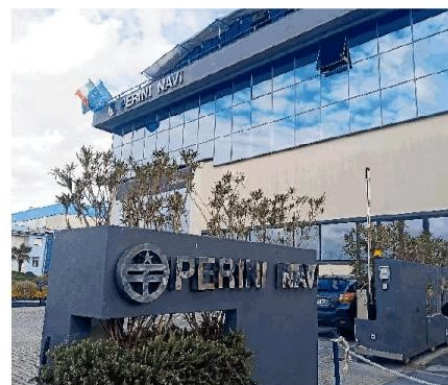
L'ingresso della sede Perini Navi in Darsena
